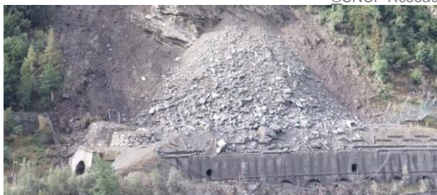
Tunnel ferroviaire de la Brèche après l'éboulement du 27/08/23
