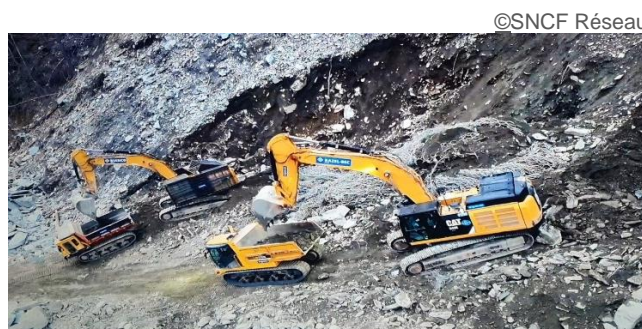
©SNCF Réseau Déblaiement de la galerie au moyen d'engins radiocommandés
